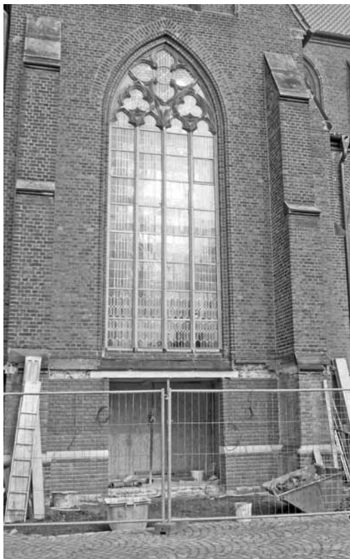
Die Arbeiten am Seiteneingang zur Parkplatzseite mit dem neu eingesetzten Fenster
