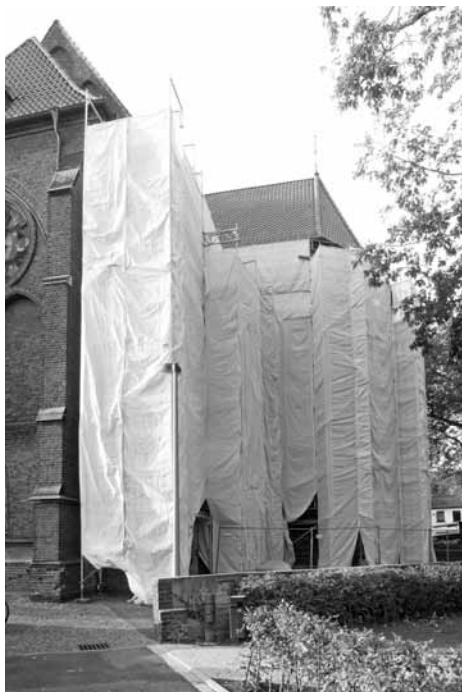
St. Vitus-Kirche eingerüstet
