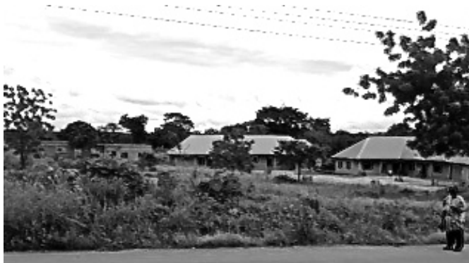
Das Schulzentrum in Umulokpa
